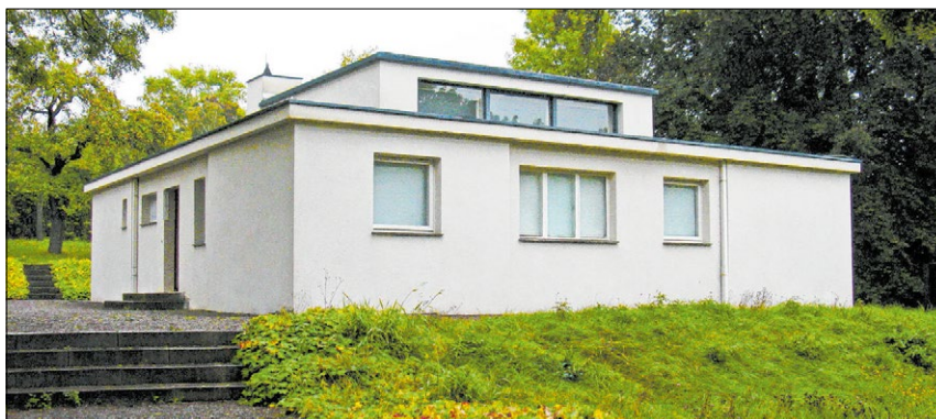
▲ Das Haus „Am Horn“, Weimars einziges Wohngebäude im Bauhaus-Stil.
