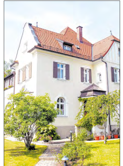
▲ Auch Altbauten können mit Erdgas versorgt werden. Foto: erdgas schwaben
