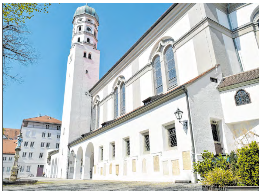
▲ Die Außenmauern von St. Peter in Dillingen sind wieder standfest.
