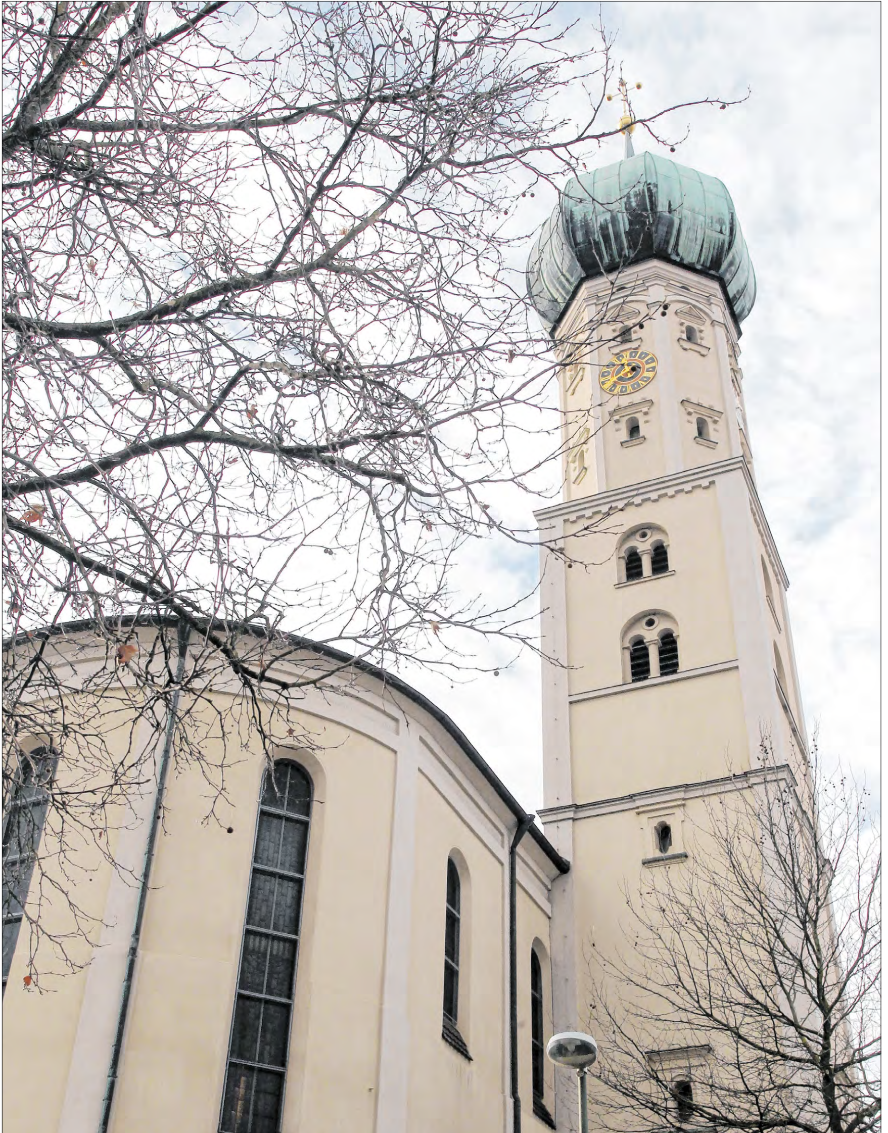
▲ Die Kirche Sankt Pankratius in Augsburg-Lechhausen wurde 1944 durch Bomben zerstört, allein der Kirchturm blieb bis auf den Zwiebelabschluss erhalten. Schon 1945 begann man mit dem Wiederaufbau. 1990 wurde das Kirchenäußere von Sankt Pankratius renoviert und instand gesetzt. Foto: Zoepf
