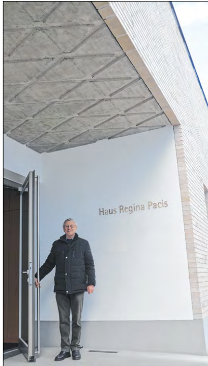
▲ Kirchenpfleger Johann Pregel am Eingang. Deutlich ist bei der Untersicht eine Rautenstruktur zu erkennen. Sie entspricht der vorhandenen Decke im Durchgang des Sakristeigebäudes.
