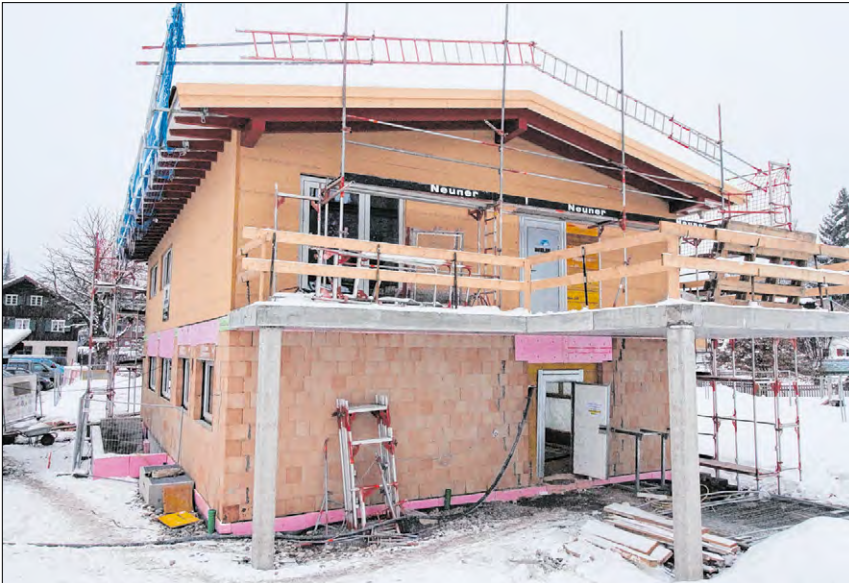
▲ Unten massiv, oben Holz: Der Rohbau des 2,1 Millionen Euro teuren Kindergarten-Anbaus in Oberstaufen steht bereits. Foto: Winkler
