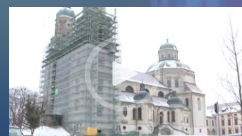
Sanierung St. Lorenz Basilika Kempten
