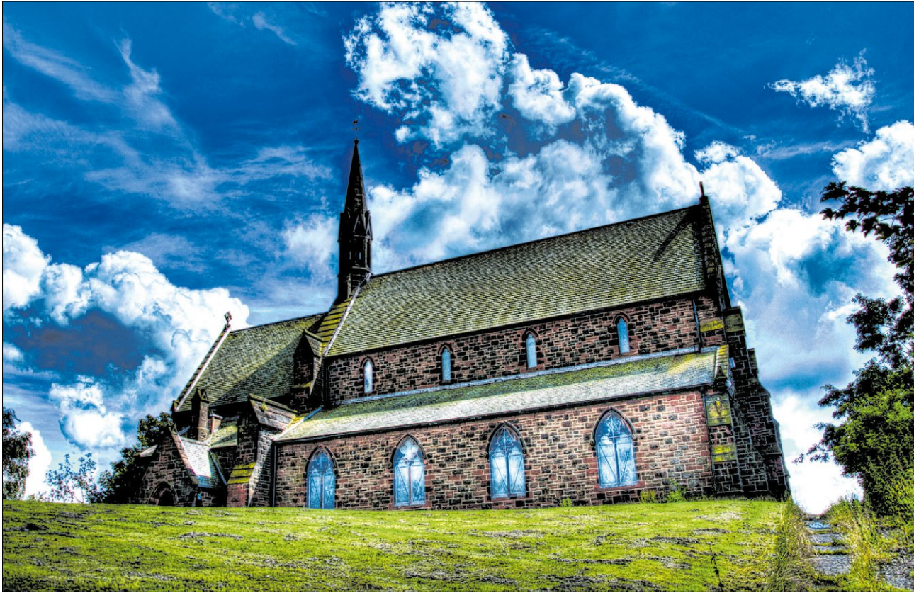
▲ Für die anglikanischen Dorfgemeinden in England sind schwere Zeiten angebrochen: Osteuropäische Diebesbanden stehlen ihre Kirchendächer. Die Versicherungen zahlen nur einen Bruchteil des Schadens. Symbolfotos: gem, Tim Reckmann/pixelio.de
