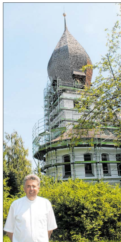
▲ Dekan Anton Brandstetter ist froh, dass er vor seinem Weggang noch die Sanierung der Weßlinger Pfarrkirche Christkönig anstoßen konnte. Foto: Reitzig
