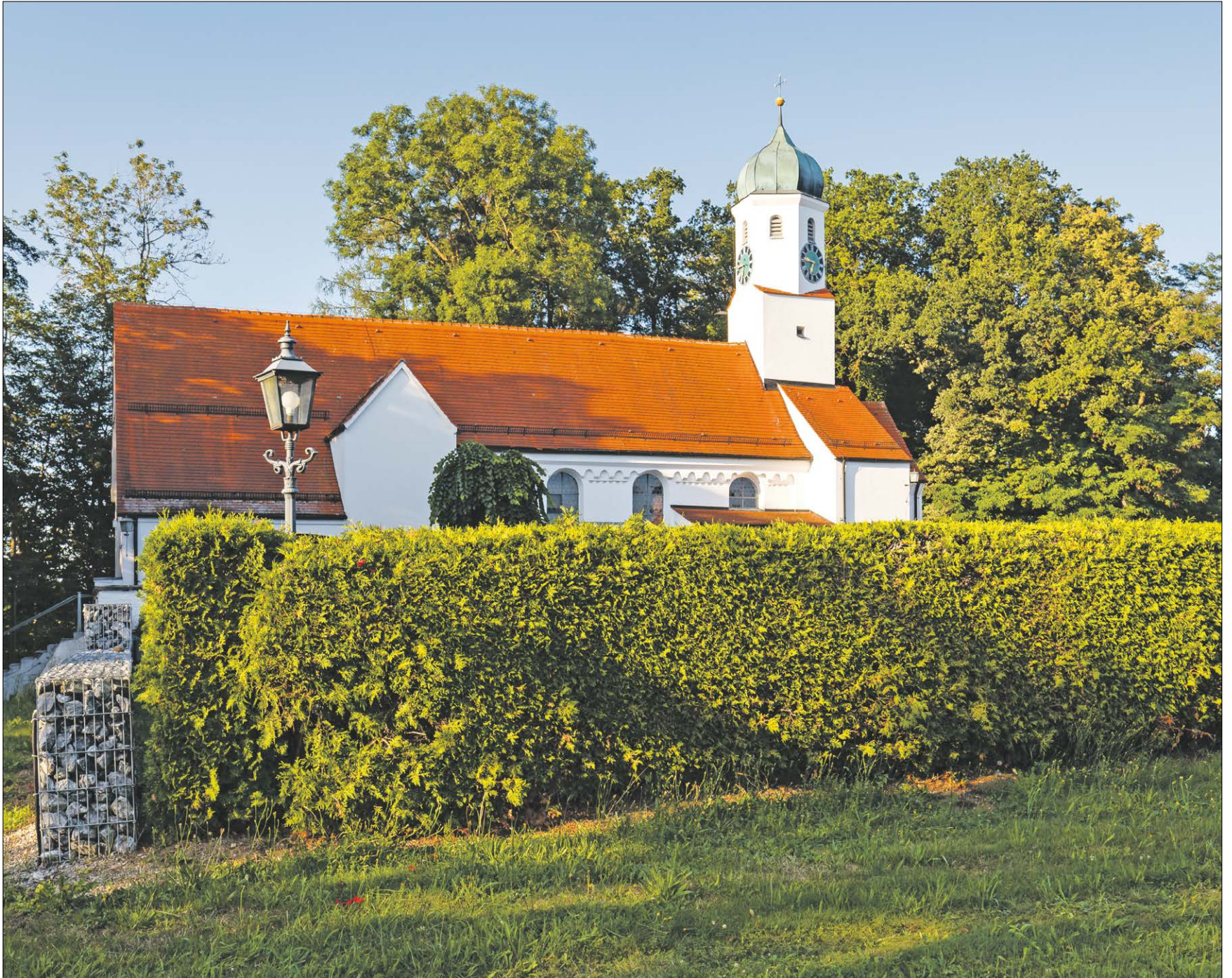
▲ Das Fundament der Heilig Kreuz Kirche in Eurasburg am nördlichen Rand eines Burgstalls, vermutlich aus dem 10. Jahrhundert, stammt aus der Zeit vor 1180. Im Kern ist die Kirche romanisch und datiert vermutlich auf die zweite Hälfte des 12. Jahrhunderts. 1550 wurde die Kirche umgebaut, worauf unter anderem Reste einer gotischen Ausmalung hinweisen. 1580 ist erstmals das Patrozinium Heilig Kreuz bezeugt. 1764/65 wurde eine Sakristei ergänzt und das Chordach geändert. Später wurde der ursprüngliche Dachreiter zu einem Vierecksturm mit Satteldach ausgebaut, auf welchen 1764 ein Sechsecksturm mit Zwiebelhaube aufgesetzt wurde. 1875 wurde die Kirche nach Plänen des Friedberger Maurermeisters Xaver Ilg um vier Meter verlängert und die Ausstattung wurde von Eduard Baldauf und C. Port neugotisch umgestaltet. Der Stuck in Stile des Bandlwerkstücks stammt aus dem Jahre 1923/24. Das Deckengemälde, welches die Kreuzauffindung durch die hl. Helena zeigt, wurde von Hans Kögl aus Pasing erstellt. Die
