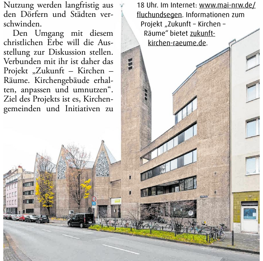
▲ St. Gertrud in Köln wurde im Stil des Brutalismus errichtet.
