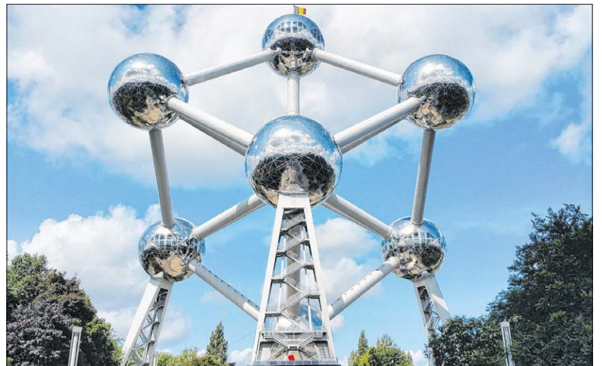
▲ Das Brüsseler Atomium ist 102 Meter hoch und stellt ein stark vergrößertes Kristallmodell des Eisens dar. Die neun „Atome“ sind mit 23 Meter langen Röhren verbunden, die Verbindungsgänge und Rolltreppen enthalten. Foto: gem
