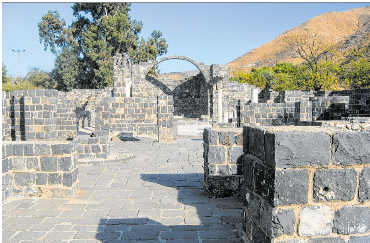
▲ Nach den Ausgrabungen wurde die byzantinische Basilika von Kursi teilweise rekonstruiert. Man verwendete Basaltgestein.
