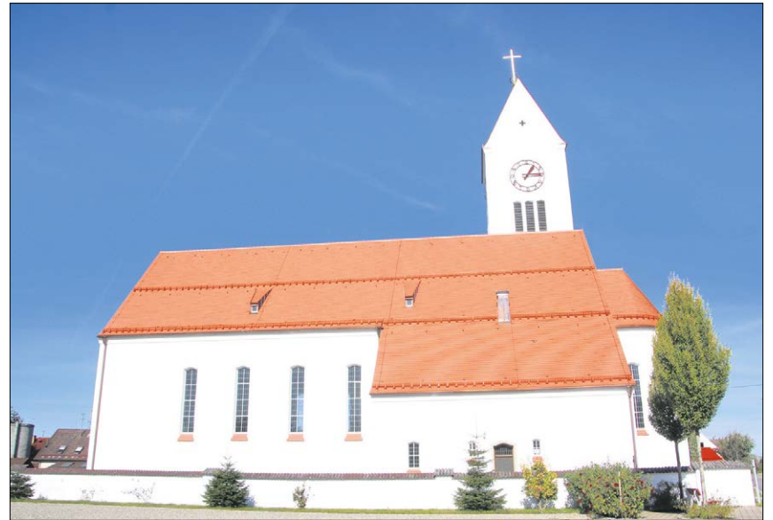
▲ Das Turmkreuz in Unterkammlach hatte bei einem Blitzschlag 2018 Schaden genommen. Im Zuge der Sanierung wurde es wieder hergerichtet. Fotos: Friebel
