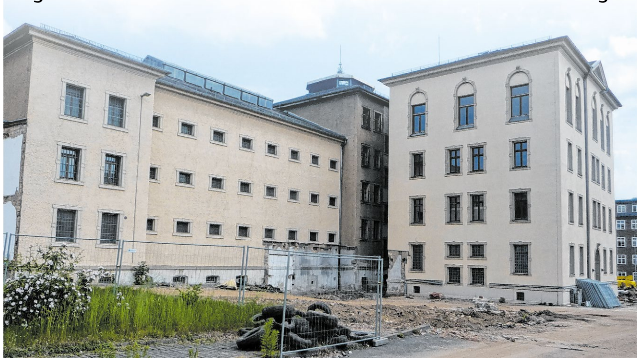
▲ Noch wird hier gearbeitet: Im einstigen Stasi-Knast in Chemnitz-Kaßberg soll bis Herbst 2021 eine Gedenkstätte entstehen.
