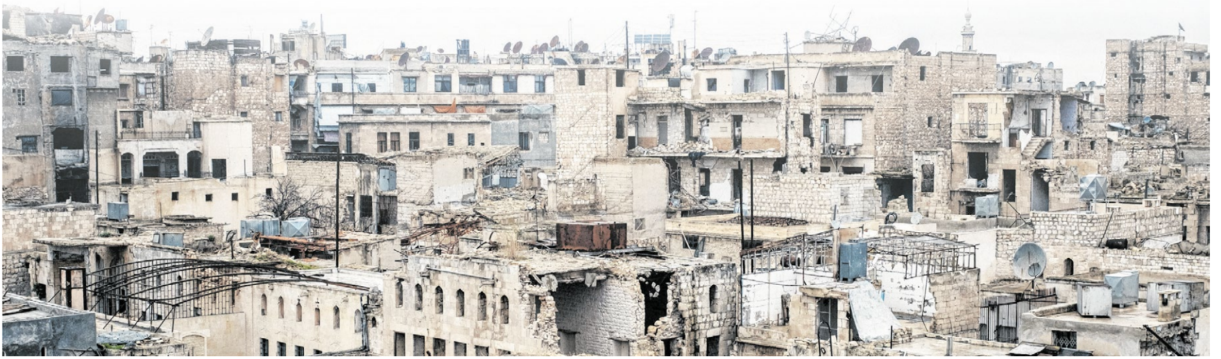
▲ Die Narben des Kriegs sind sichtbar: Aleppo wurde durch die Kämpfe stark in Mitleidenschaft gezogen. Heute hilft hier die Kirche beim Neubeginn.
