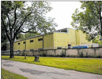
▲ Der Neubau des Elefantenhauses mit Außenanlage ist weit fortgeschritten.
