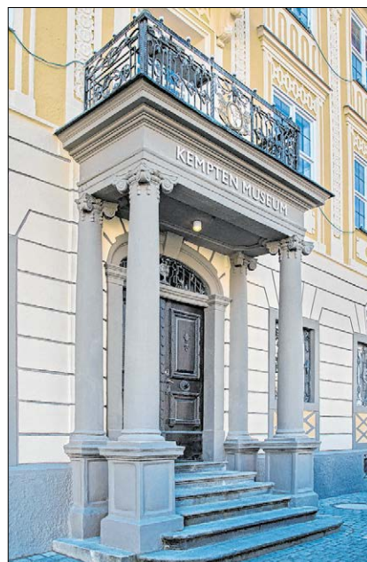
▲ Das Zumsteinhaus wurde 1802 von der aus Savoyen stammenden Kaufmannsfamilie Zumstein de la Pierre als bürgerliches Palais erbaut. Früher weißgrau, erhielt es wieder den ockerfarbenen Anstrich wie nach der Erbauung 1802.
