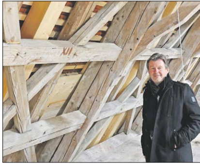
▲ Architekt Christian Eger am Gebälk des Dachstuhls, der aufwendig saniert wurde.
