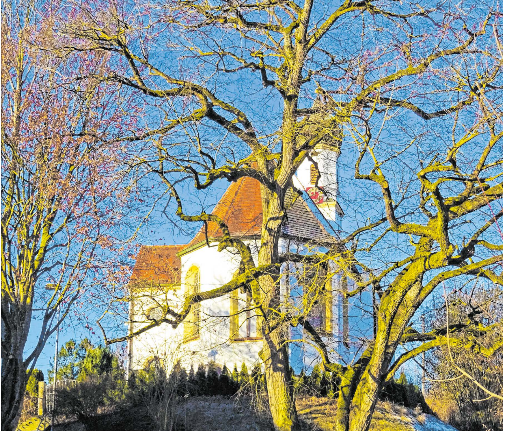
▲ Die Pfarrkirche St. Nikolaus in Reichertshofen, Gemeinde Mittelneufnach, weist einen gotischen Kern auf. 1710 wurde sie grundlegend verändert. Sie ist ein einschiffiger Bau mit eingezogenem, dreiseitig geschlossenem Chor. Der Turm an der Westfassade ist als Dachreiter ausgebildet. Foto: Krünes
