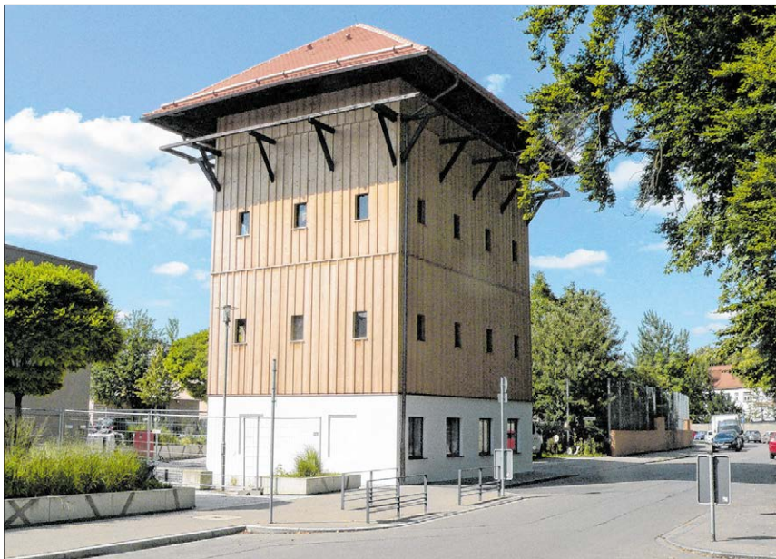
▲ Der renovierte Augsburger Färberturm. Gut sichtbar die Balken unterhalb der Dachtraufe, an denen die Stoffbahnen zum Trocknen aufgehängt wurden. Foto: Alt
