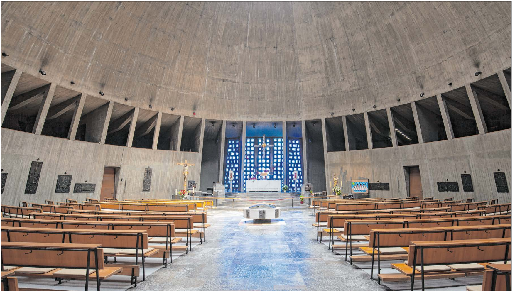
▲ Der markante Zentralbau der Don-Bosco-Kirche im Augsburger Herrenbachviertel wird von einer 18 Meter hohen Stahlbetonkuppel überspannt, die einen Durchmesser von 30 Metern aufweist. Licht flutet in das Gotteshaus durch den Scheitel der verglasten Kuppel. Die bläulich gefärbten Chorfenster verleihen dem Kirchenraum eine mystische Aura. Über dem Altar zieht ein großes Kreuz die Blicke auf sich. Foto: Banner
