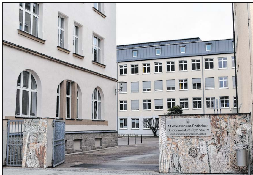
▲ Ein Teil der Gebäude der St.-Bonaventura-Schulen in Dillingen wird umgebaut. Dort entsteht die neue Fachoberschule. Foto: Bunk
