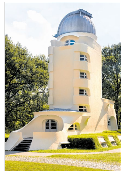
▲ Der Einsteininturm, erbaut 1920/21, gilt als Zeugnis expressionistisch-organischer Architektur. Er wurde als astronomische Beobachtungsstation errichtet. Fotos: pm
