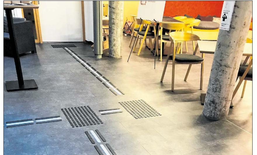
▲ Ein taktiles Leitsystem am Boden erleichtert sehbehinderten Menschen den Besuch des Begegnungszentrums Divano. Fotos: oh
