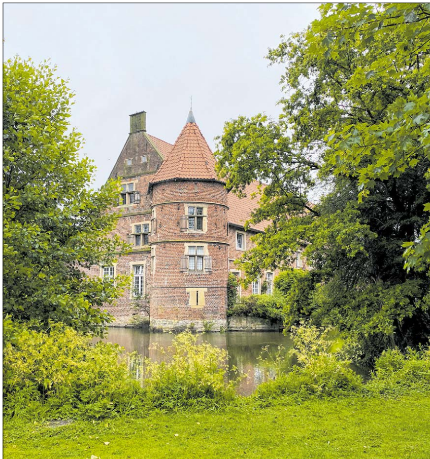
▲ Haus Vögeding, eine ehemalige viertürmige Wasseranlage, am Rand des Lyrikwegs. Hier soll die Dichterin auf ihren Spaziergängen gern eingekehrt sein, um ein Glas Buttermilch zu trinken. Fotos: KNA
