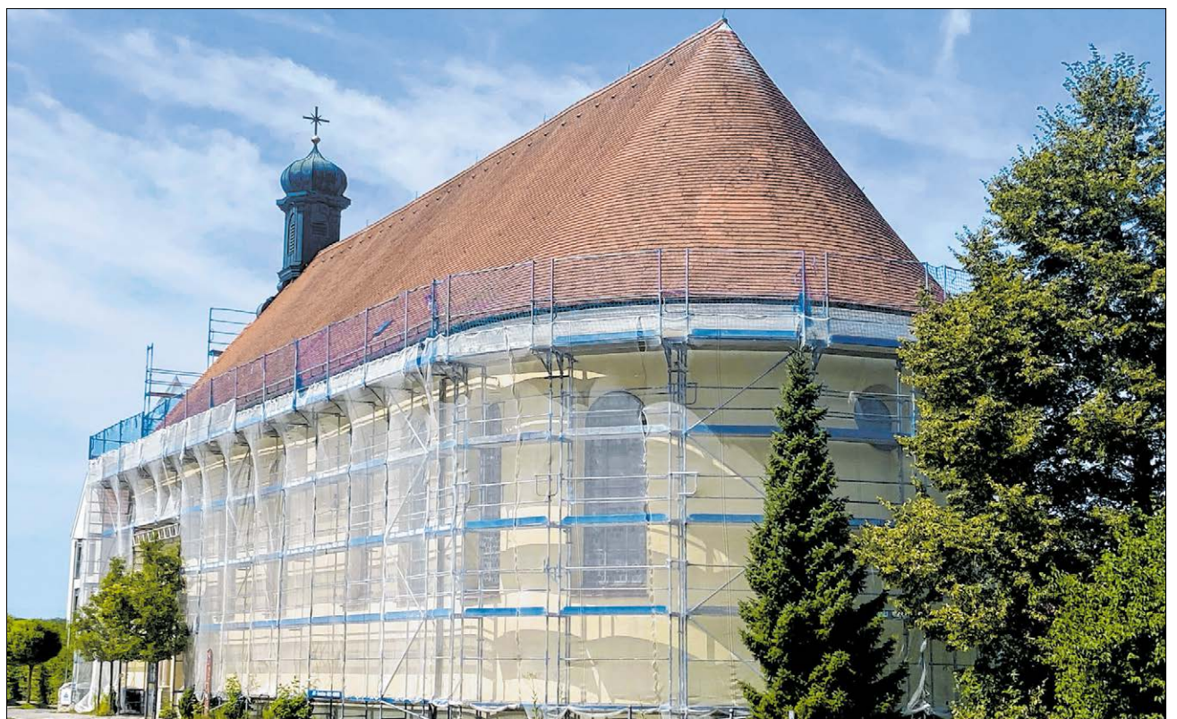
▲ Die Wallfahrtskirche St. Afra im Felde bei Friedberg wird 2022 einer statischen Sanierung und Innenrenovierung unterzogen. „Unzählige Generationen haben an dieser Stelle schon die heilige Afra als Patronin unseres Bistums verehrt. Es ist uns Verpflichtung und Ansporn zugleich, diese alte Tradition fortzuführen“, sagt Friedbergs Stadtpfarrer Pater Steffen Brühl. Der Überlieferung zufolge steht die Wallfahrtskirche St. Afra im Felde am Ort einer ehemaligen Lechinsel, auf der im Jahr 304 die frühchristliche Konvertitin Afra von Augsburg im Rahmen der Christenverfolgung hingerichtet wurde. Foto: oh
