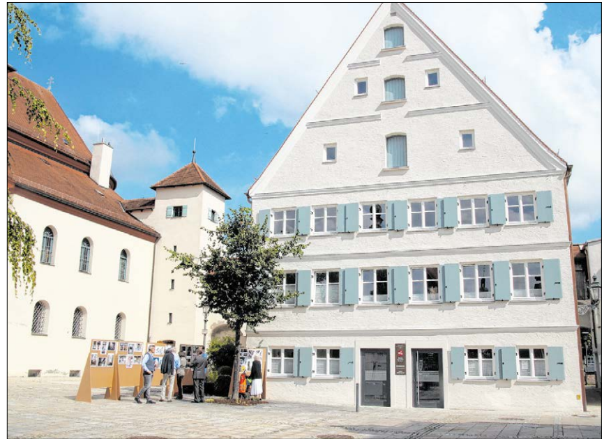
▲ Das Mindelheimer Mesnerhaus aus dem 17. Jahrhundert ist eine schicke Bereicherung des Ensembles um die Pfarrkirche. Und erweist sich mit modernen Büros (kleines Foto oben) ideal als Verwaltungsgebäude der Pfarreiengemeinschaft.
