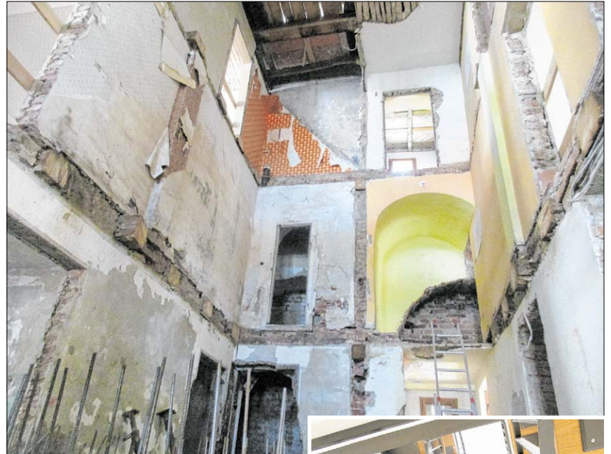
▲ ► Einen Eindruck vom Aufwand, der betrieben werden musste, vermittelt das obige Foto. Unter anderem wurde eine Mittelwand aus dem Jahr 1815 ersetzt, die das Gebäude im Inneren in zwei Einheiten getrennt hatte. Statt der alten Stiegen gibt es nun ein modernes Treppenhaus samt Lift (rechts). Fotos: Issing
