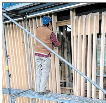
▲ Bevor der erste Schnee fällt, wurden die Holzlamellen angebracht.
