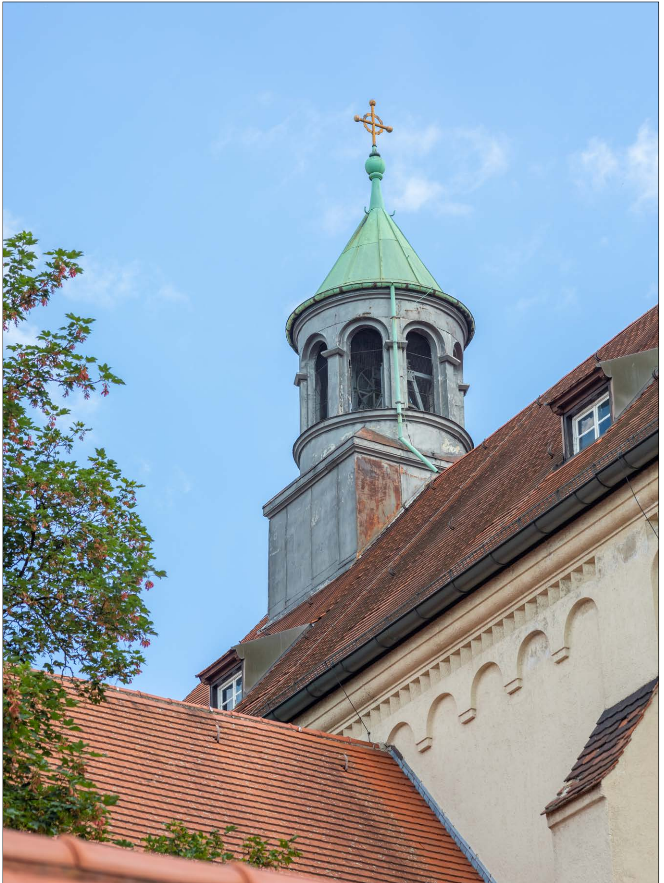
▲ Das Kloster St. Sebastian war bis 2008 ein Kapuzinerkloster in Augsburg-Oberhausen rechts der Wertach. Es ist auf drei Seiten vom Werksgelände des Maschinenbauunternehmens MAN umschlossen, an der vierten Seite grenzt es an die Sebastianstraße. Die früher zu diesem Kloster gehörende Kirche St. Sebastian ist eine der wenigen Augsburger Kirchen, die den Zweiten Weltkrieg unbeschädigt überstanden. Sie steht unter Denkmalschutz. Foto: Banner
