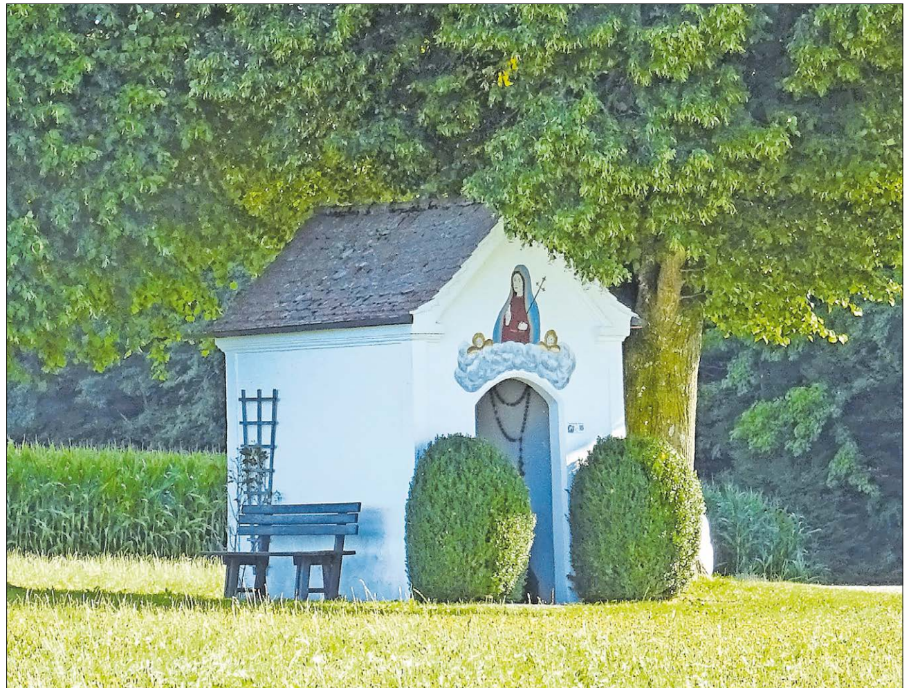
▲ Die Feldkapelle der 14 Nothelfer liegt direkt am Mittelneufacher Weg der Besinnung. Dort lässt es sich wunderbar rasten und nach einem Gebet die Aussicht genießen. Die kleine Kapelle wurde 1878 durch die Gebrüder Schorer als Dank für die gute Rückkehr aus dem Krieg 1870/1871 erbaut. Ursprünglich war sie mit gemalten Nothelfertafeln ausgestattet, die nach mehreren Einbrüchen ausgelagert wurden. Die Muttergottesstatue wurde durch ein gemaltes Bild ersetzt. Foto: Krünes
