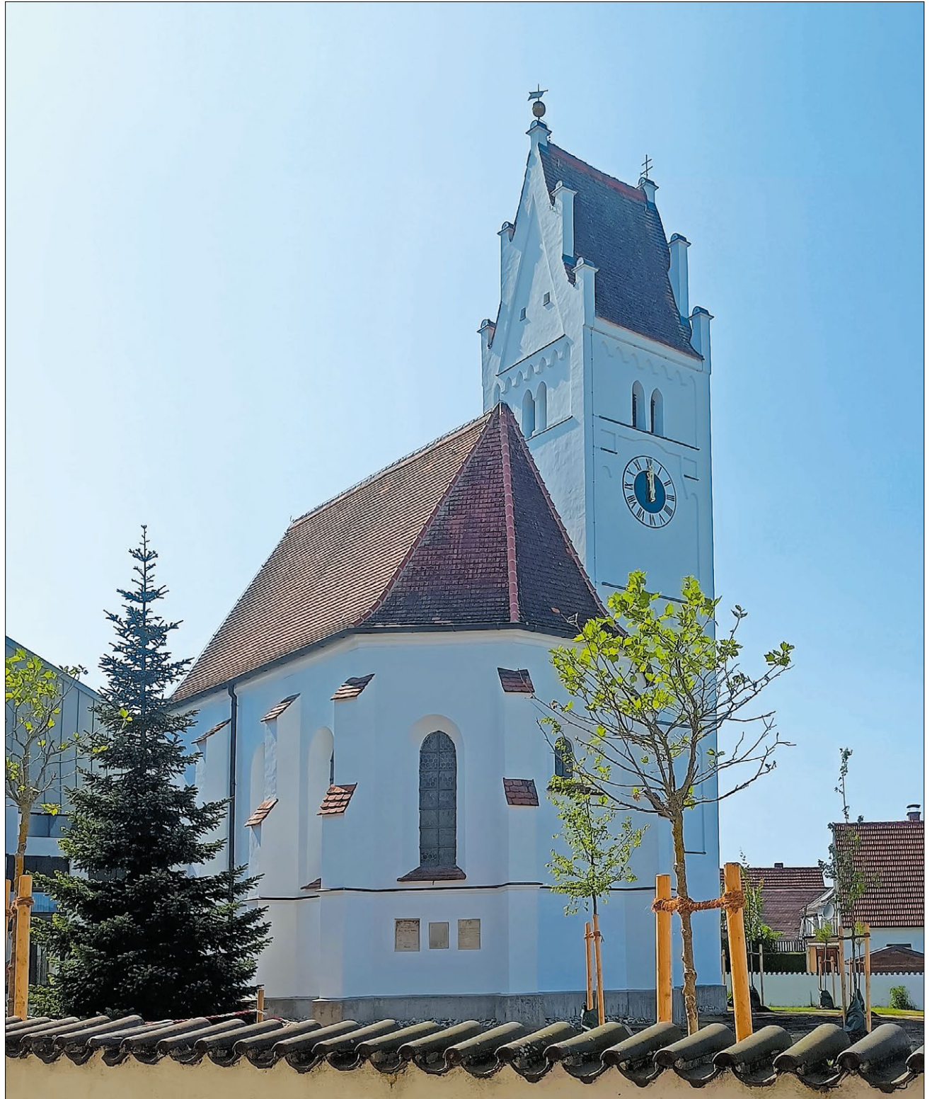
▲ Die Ursprünge der Kirche St. Peter und Paul im Aichacher Ortsteil Ecknach gehen bis in das 9. Jahrhundert zurück. Nach der Zerstörung durch die Ungarn wurde sie 955 wieder aufgebaut. 1972 wurde das romanische Kirchenschiff durch ein modernes ersetzt (ganz links im Bild). 2022 fanden umfangreiche Renovierungsarbeiten statt, sodass das Kirchlein heute wieder im neuen Glanz erstrahlt.
