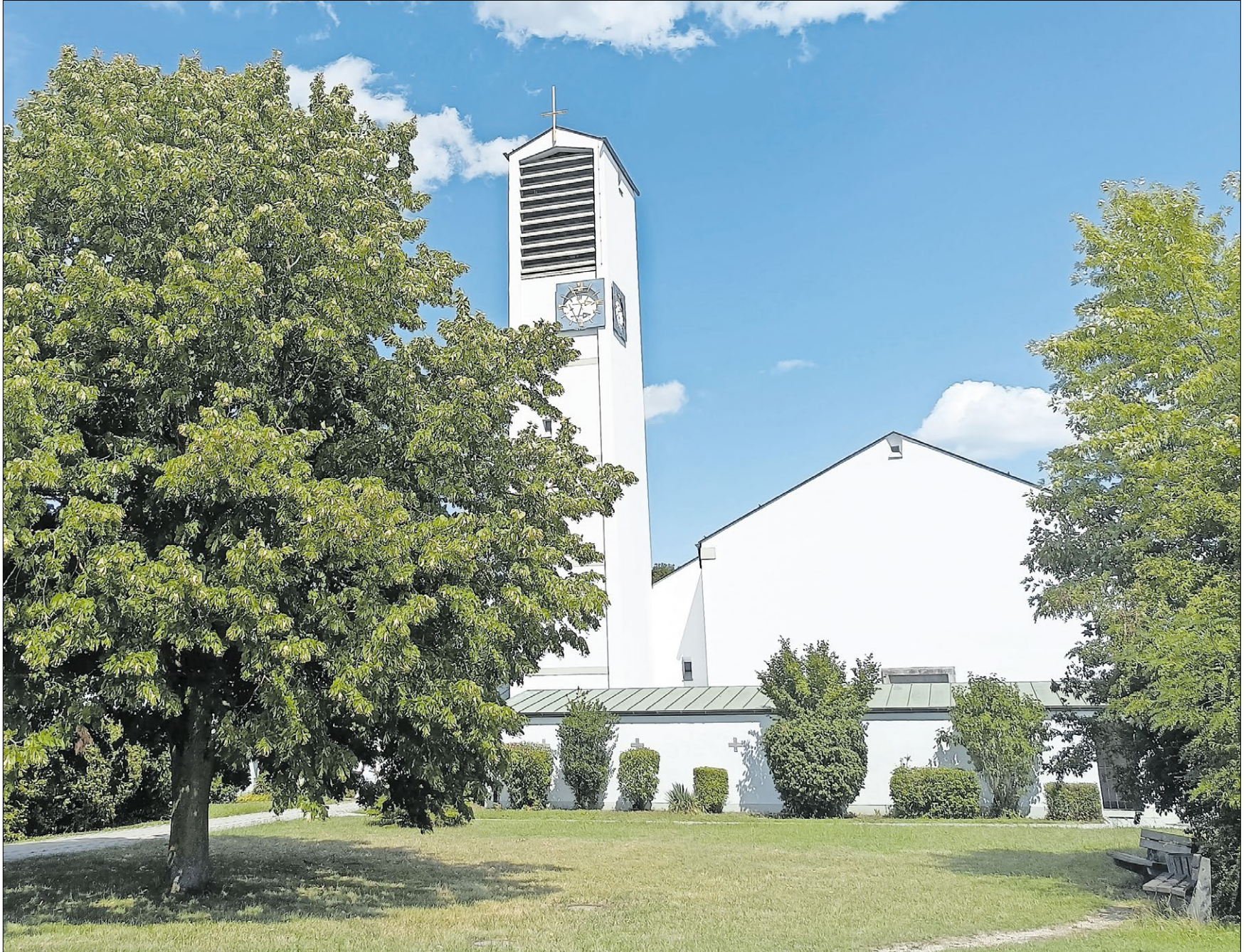
▲ Die Christkönigskirche im Zentrum von Nordendorf wurde am 3. Juni 1961 von Bischof Joseph Freundorfer geweiht. In den 1970er Jahren wurde die alte Kirche St. Jakobus abgerissen, da sie seit dem Kirchenneubau nicht mehr genutzt wurde und dem Verfall preisgegeben war. Aufgrund vieler Spenden konnte die Kirche im Inneren künstlerisch wertvoll ausgestattet werden. So befinden sich an der Nordseite fünf Glasfenster mit überlebensgroßen Darstellungen der Propheten Jesaja, Ezechiel, Jeremias, Daniel und Sacharja, die vom Augsburger Künstler Wolfgang Lettl geschaffen wurden. Foto: Beck
