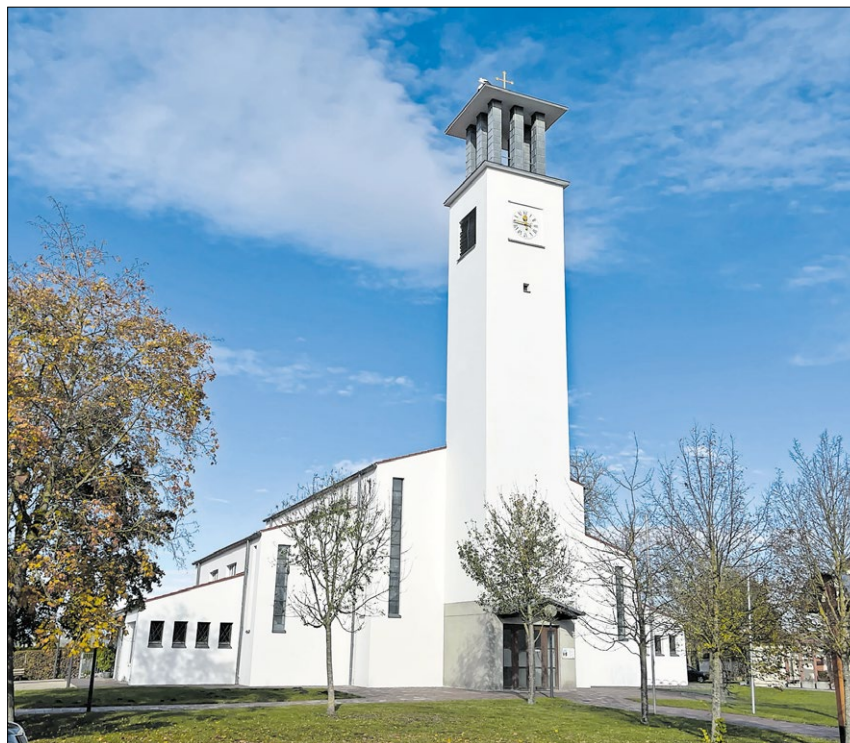
▲ Vor 35 Jahren wurde die Kirche St. Joseph in Untermaxfeld geweiht. Nach der Außensanierung strahlt sie wieder in hellem Weiß. Fotos: Hammerl
