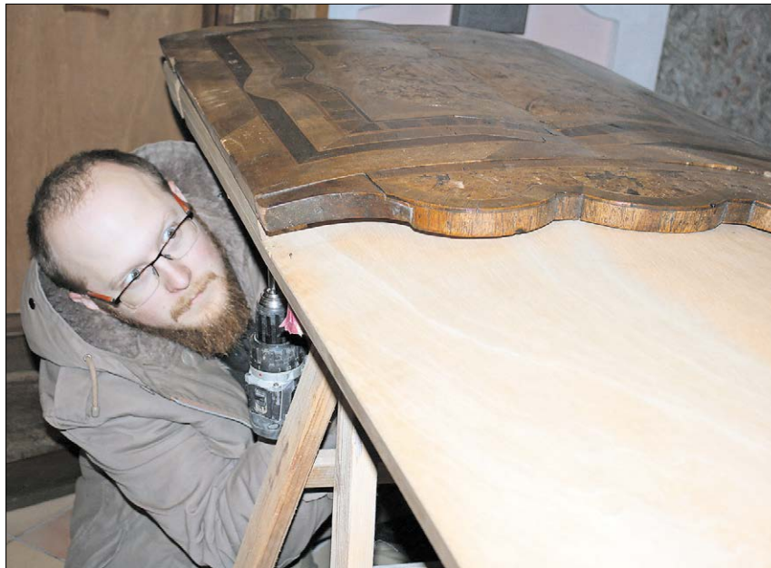
▲ An der Tür des aus Nussbaumholz gefertigten Beichtstuhls im Langhaus Nord wird die Marketerie sorgsam vervollständigt. Fotos: Reitzig
