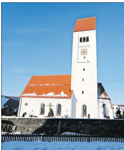
▲ Die Kirche St. Dionysius ist seit Herbst 2021 renoviert worden. Fotos: Wind
