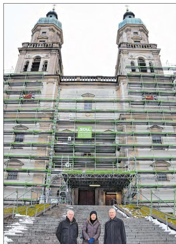
driften auseinander und müssen auf zwei Ebenen mit Ankern verspannt werden. „Der Hügel, auf dem die Basilika steht, ist aufgeschüttet und bewegt sich“, erklärt sie. Auch das Dach im Langhaus und in der Sakristei drücke sich durch und müsse stabilisiert werden.
