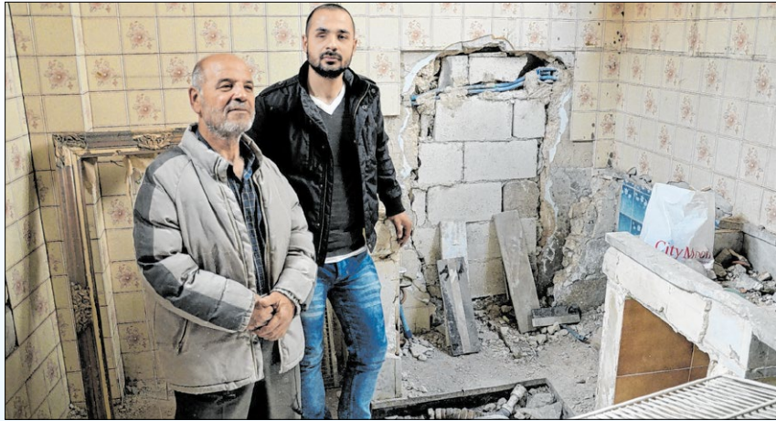
▲ Elias (links) und Baschar Ghattas begutachten die Baufortschritte in ihrem Haus.
