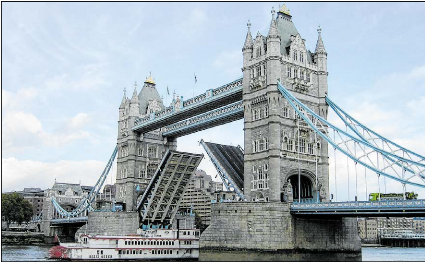
▲ Die Brückenhälften der Tower Bridge heben sich für die Schiffe. Die sogenannten Baskülen wiegen jeweils 1045 Tonnen – sie sind damit fast so schwer wie 300 Autos.
