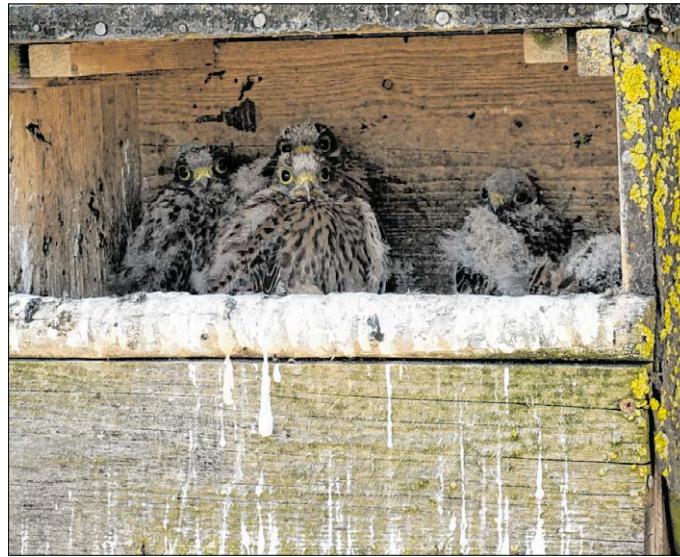
Erst wenn die fünf jungen Turmfalken den Nistkasten am Kirchturm von St. Georg in Haunstetten verlassen haben, können die Sanierungsarbeiten am Glockengestühl beginnen.
