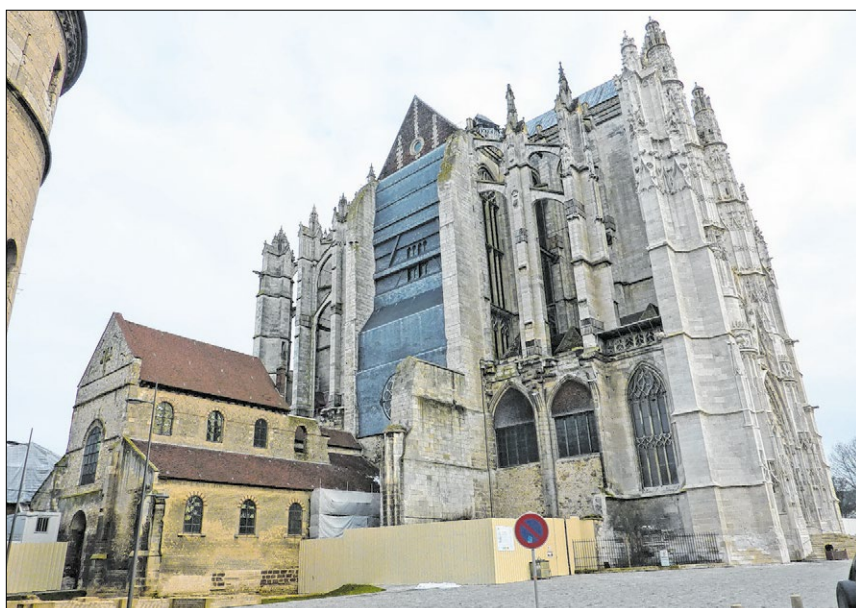
▲ Die Errichtung des Langhauses wurde nie in Angriff genommen. An dessen Stelle steht noch immer das Schiff des Vorgängerbaus aus dem 10. Jahrhundert. Foto: gem
