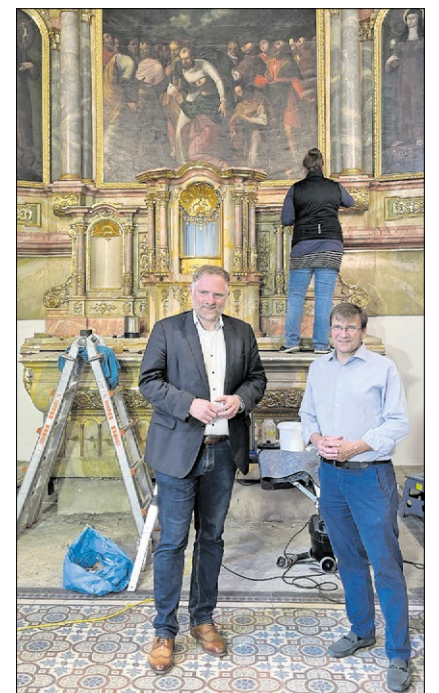
▲ Peter Aumer (links) und Michael Eibl (rechts) vor dem Altar während der laufenden Sanierungsarbeiten. Foto: Allgeyer
