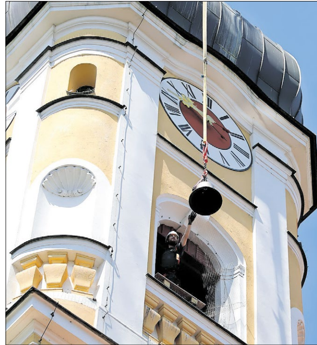
◀ In den Glockenturm der Pfarrkirche St. Georg in Obertraubling wurden die 25 großen und kleineren Glocken für ein Glockenspiel mittels eines Schwerlastenkrans gehoben.
