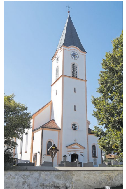
▲ Die Filialkirche St. Nikolaus in Rimbach. Foto: Mohr
