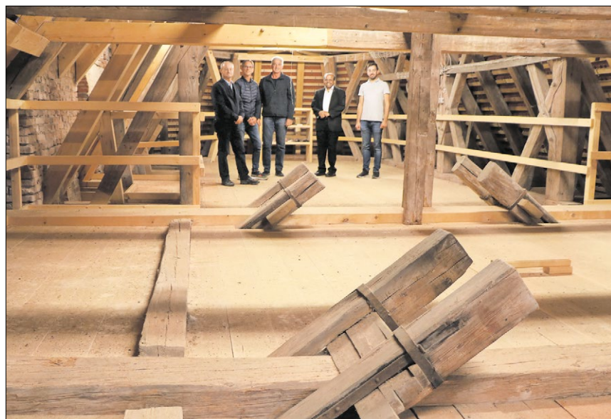
▲ Im Dachraum der Ahamer Kirche ist eine seltene Gewölbeseicherung zu sehen.
