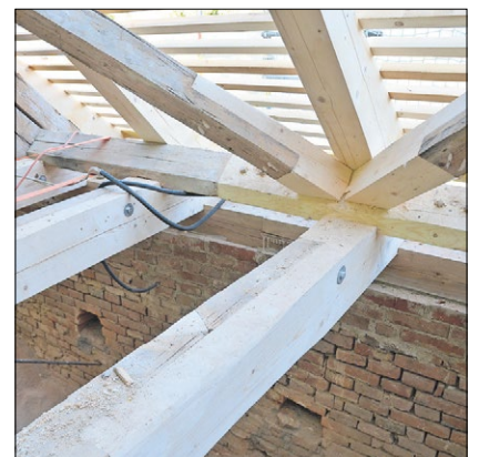
▲ Dachkonstruktion bei der Friedhofskirche in Schönbach zwischen Regensburg und Straubing. Gefragt sind alte Zimmermannstechniken. Und unten: Detail an der Traufe des Kirchendaches in Schönbach. ▼
