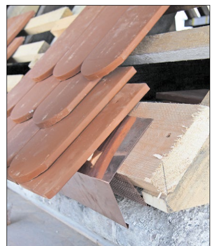
▲ Dachkonstruktion bei der Friedhofskirche in Schönbach zwischen Regensburg und Straubing. Gefragt sind alte Zimmermannstechniken. Und unten: Detail an der Traufe des Kirchendaches in Schönbach. ▼
