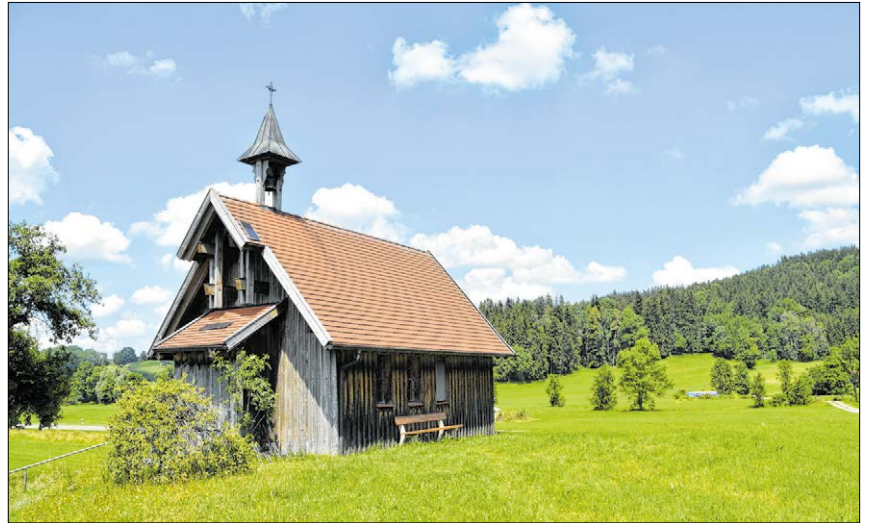
▲ Die Kreuzkapelle südlich von Engetried wird im Zuge des Baus des Hochwasserrückhaltebeckens abgebrochen. Fast an derselben Stelle des Dammbauwerks, das bis zur gegenüberliegenden Hangkante reicht, wird die Kapelle wieder aufgebaut.
