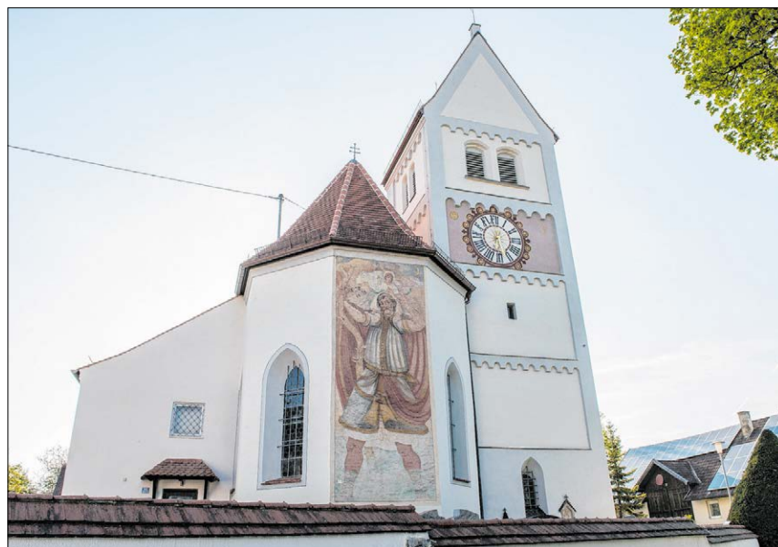
▲ Nach der Sanierung wieder ein Schmuckstück: die Pürgener Pfarrkirche. Die Rückseite des Chores schmückt ein heiliger Christophorus.
