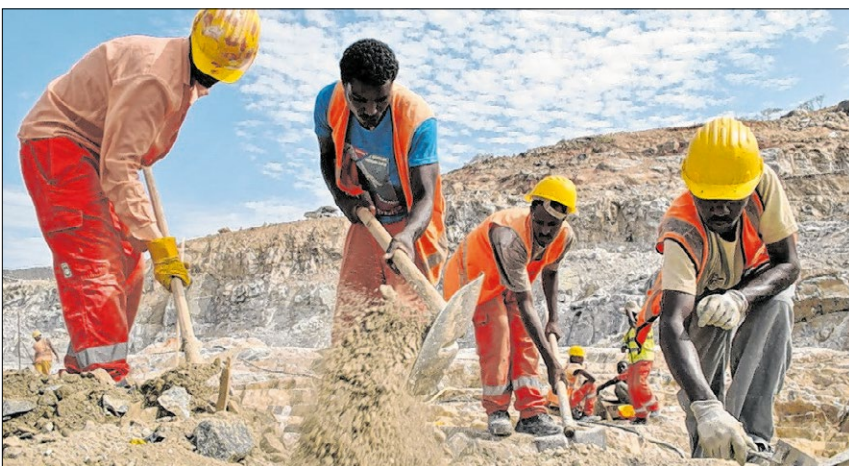
▲ Arbeiter auf der Baustelle des „Grand Ethiopian Renaissance“-Staudamms.
