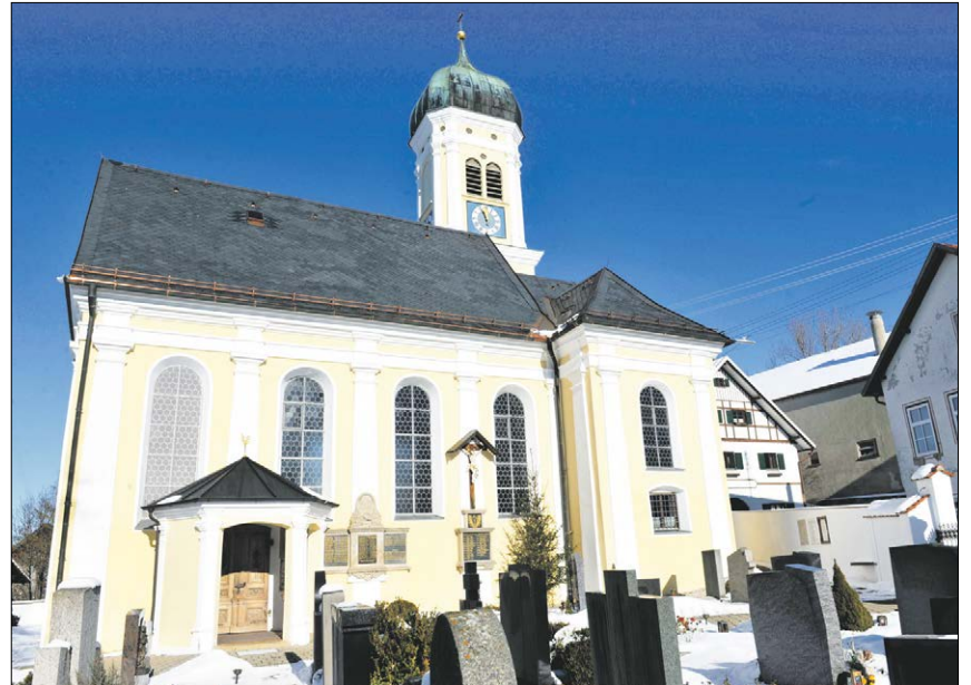
▲ In der Regel sind alte Kirchen in der Diözese mit Biberschwanzziegeln gedeckt. St. Andreas in Frankenried bildet da eine interessante Ausnahme. Die Kirche wurde mit Schiefer gedeckt, was ihr ein fast elegantes Aussehen verleiht. Fotos: Drescher (3)
