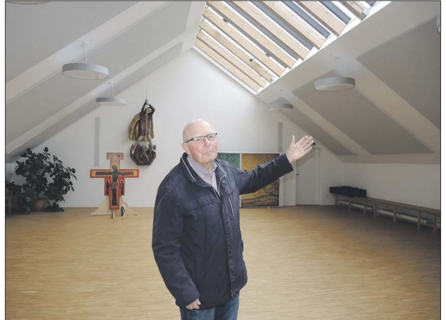
▲ Kirchenpfleger Helmut Bill zeigt auf die gedämmten Wände, die neue energiesparende Verglasung und die Maßnahmen zur Verbesserung der Akustik im Dachsaal des Pfarrheims. Fotos: Mitulla
