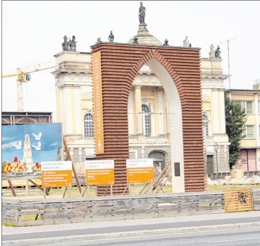
▲ Noch hat der Wiederaufbau der Garnisonkirche nicht begonnen. Lediglich der im Frühjahr 2005 zur symbolischen Grundsteinlegung rekonstruierte Gewölbebogen der Heilig-Kreuz-Kapelle steht bereits. Archivfoto: Soyke
